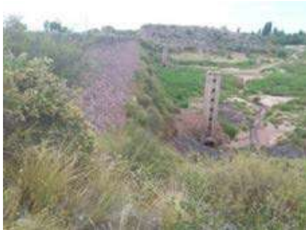
Figura 144. Vista del lateral oeste del dique Papagayos, con las dos torretas de descarga de fondo.
