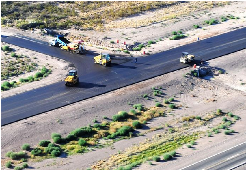
Figura 17: Trabajos preliminares sobre la Ruta 40
